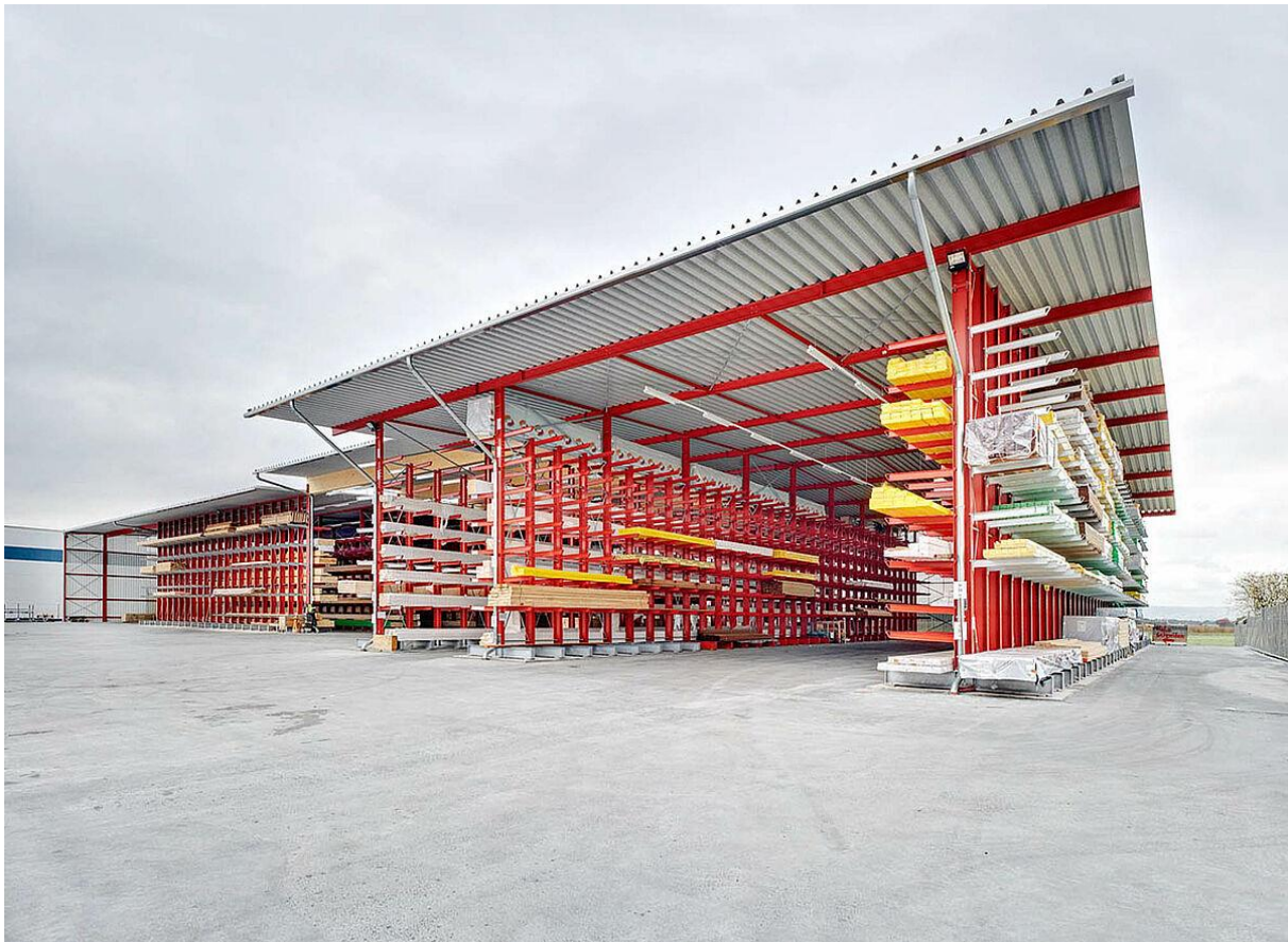
Slika 2: Natkriveno skladište drvene građe (Dostupno na:
