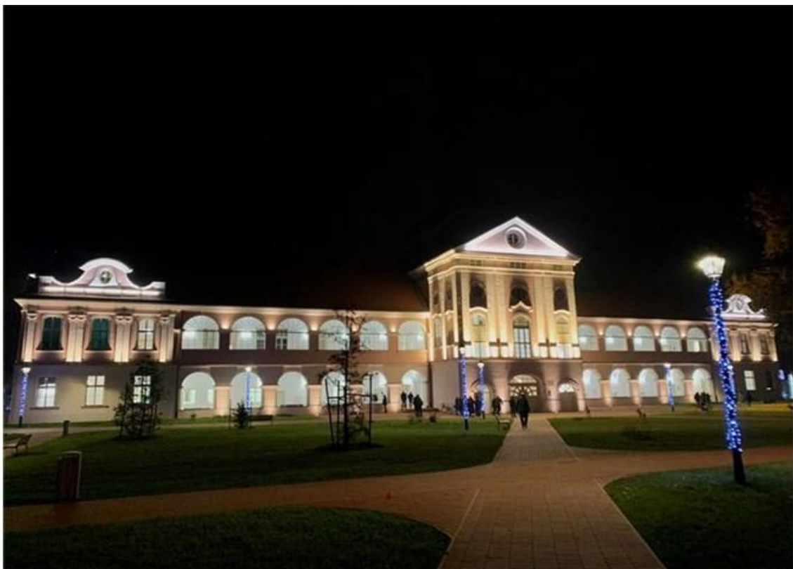
Slika 63. Original - južno pročelje, nočno svjetlo [20]
