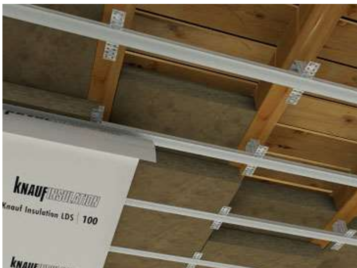
Slika 6-5. Ispravno postavljena izolacija stropa (www.knaufinsulation.hr)
