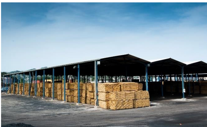
Slika 2: Natkriveno skladište- Skladište robe drvene građe (luka-ploče.hr, 2018)
