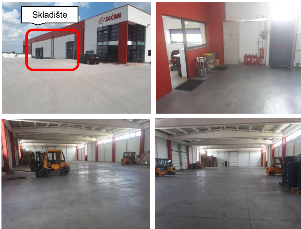
Slika 42: Skladište- S-SEČAN d.o.o. (Izvor: poduzeće S-SEČAN d.o.o.)
