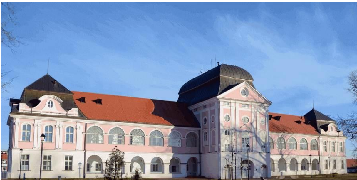
Slika 59. Original - južno pročelje [18]
