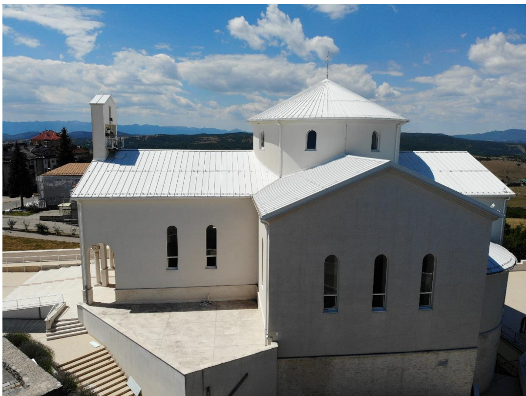
Slika 16. Istočno pročelje crkve (vlastita izrada 31.7.2022.)
