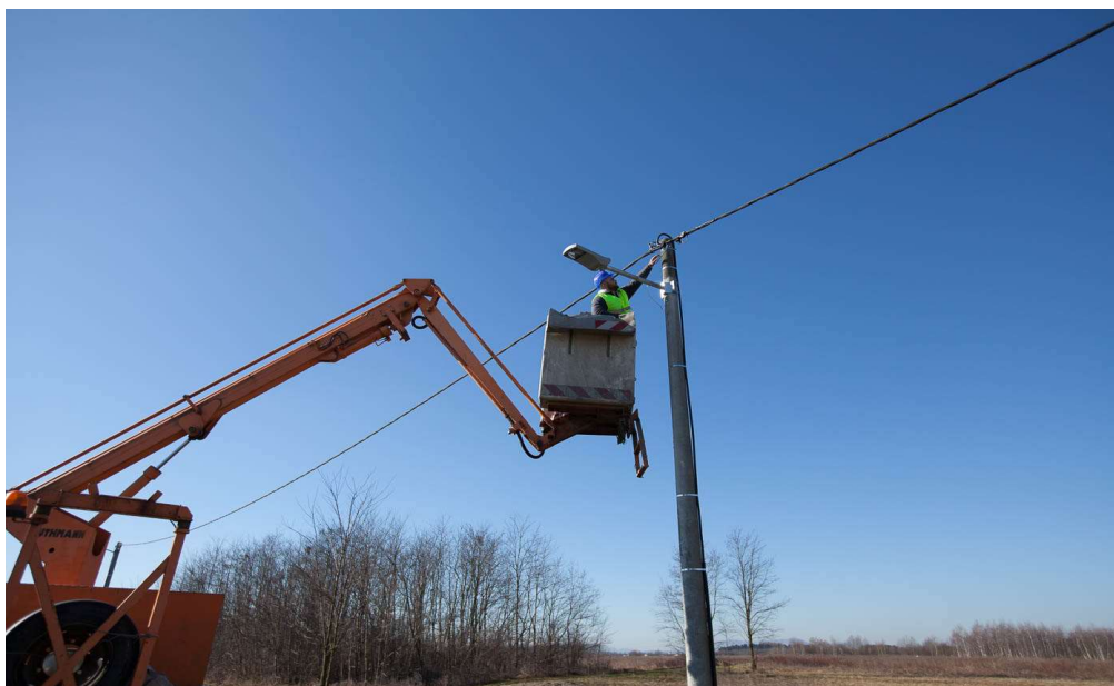
Slika 4. Instalacija LED rasvjete
