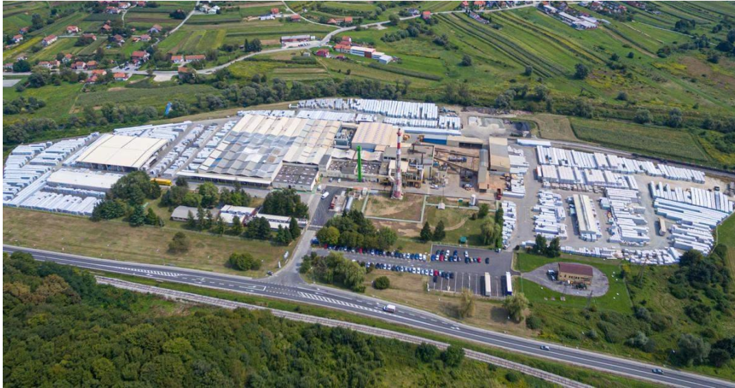
Slika 13. Knauf Insulation d.o.o. u Novom Marofu (knaufinsulation.hr, 2.11.2020.)
