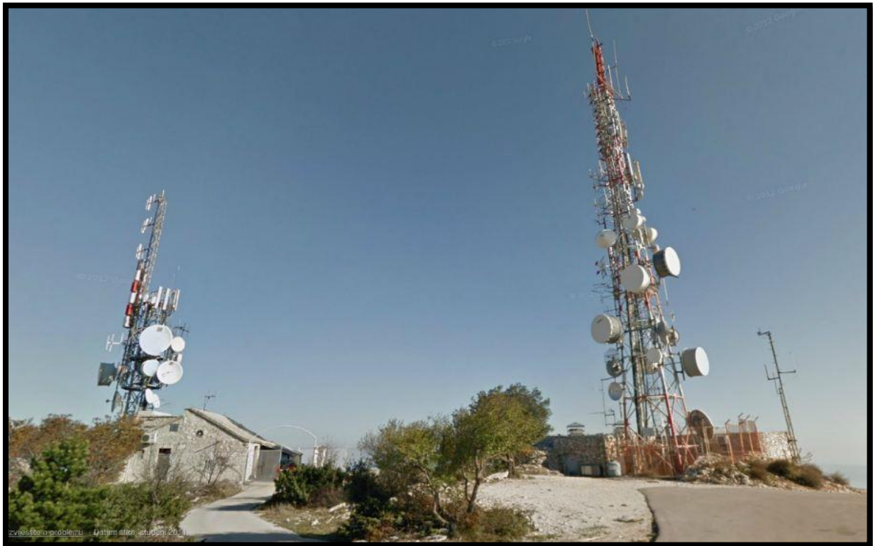
Slika 22. Primjer bazne postaje.
