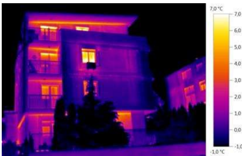
Slika 3-4. Termografski snimak zgrade iz okoliša
