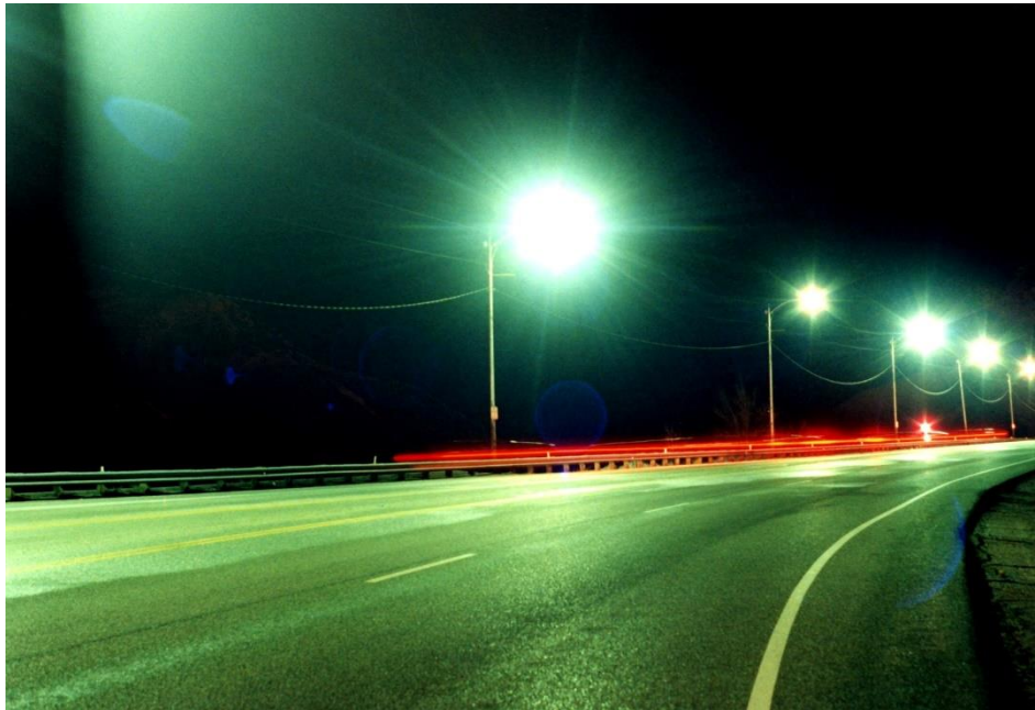
Slika 8. Prikaz bljeska na uličnoj rasvjeti ( Street lights , bez dat.)
