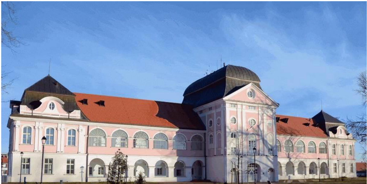
Slika 59. Original - južno pročelje [18]
