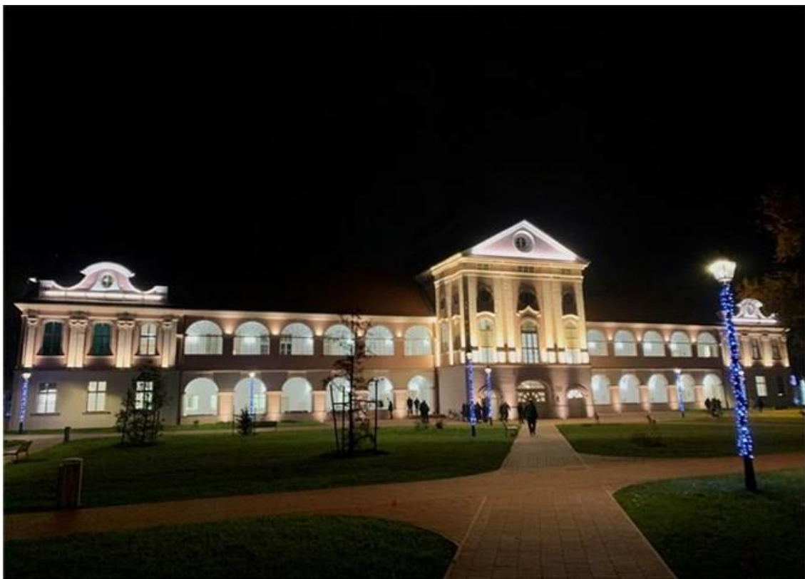
Slika 63. Original - južno pročelje, nočno svjetlo [20]
