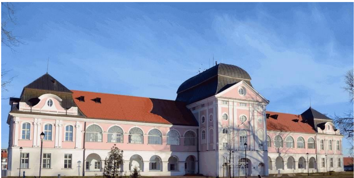
Slika 59. Original - južno pročelje [18]
