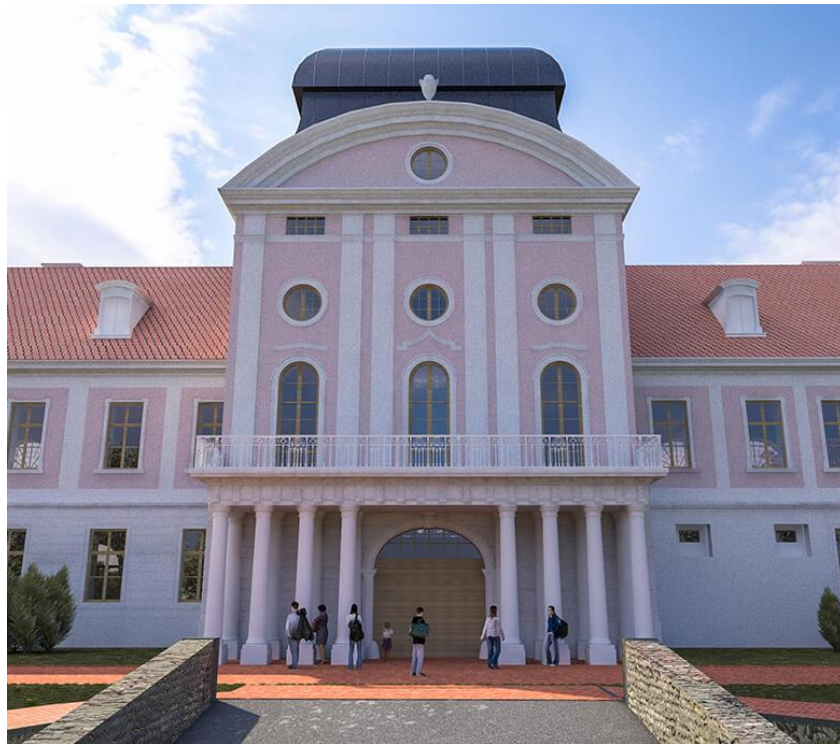
Slika 19. Sjeverno pročelje (glavni ulaz) dvorca [15]
