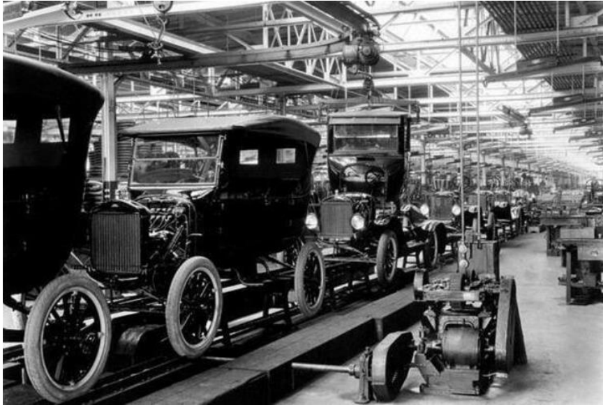
Slika 1: Proizvodna linija Forda Model T (Flickr, 2014.)
