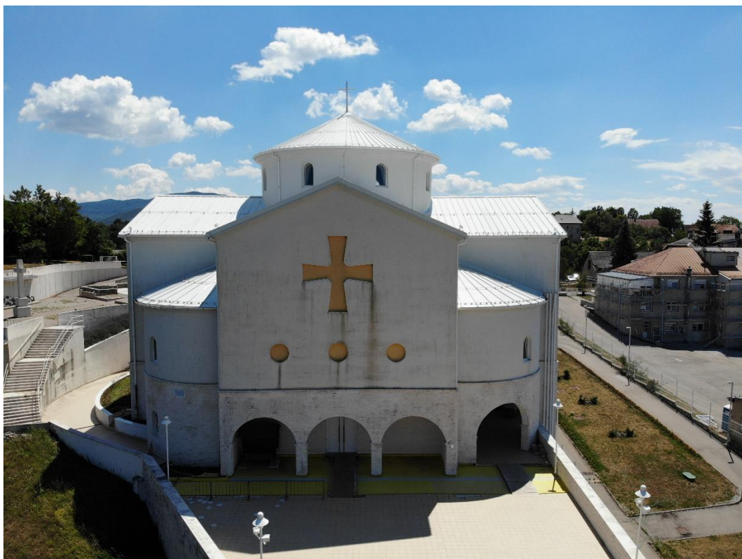
Slika 14. Sjeverno pročelje crkve – prema Krbavi (vlastita izrada 31.7.2022.)
