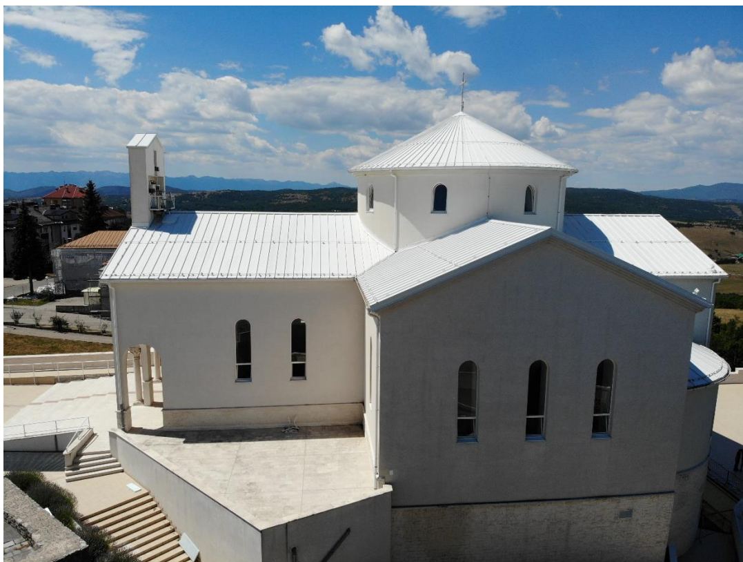
Slika 16. Istočno pročelje crkve (vlastita izrada 31.7.2022.)
