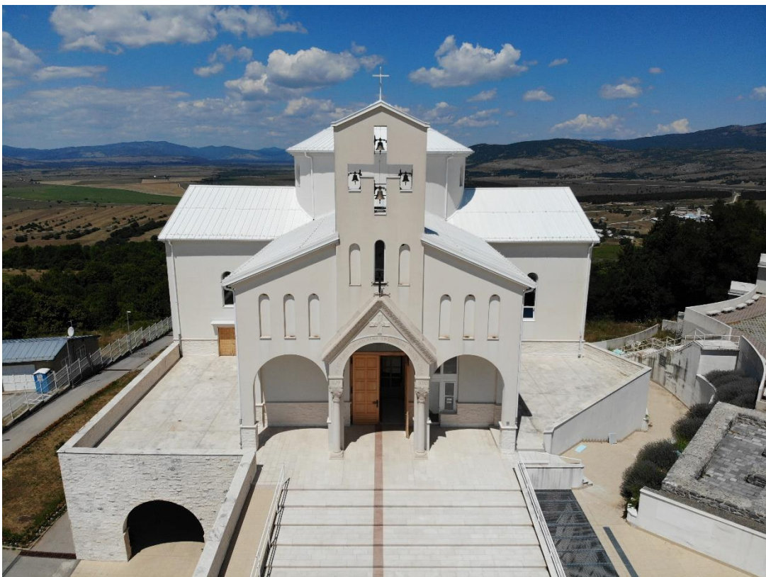
Slika 13. Južno pročelje crkve – prema cesti (vlastita izrada, 31.7.2022.)
