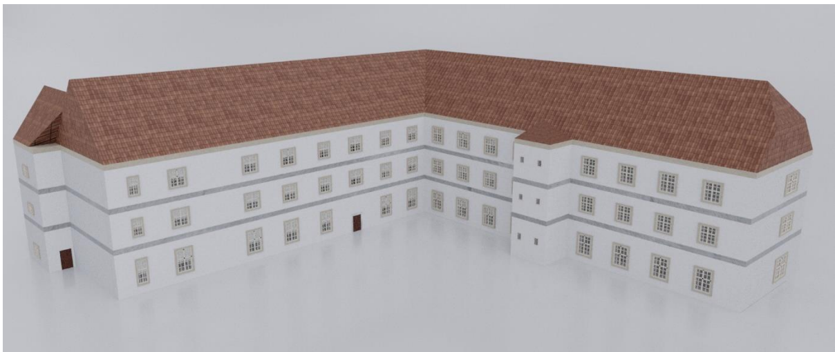
Slika 52. Južni i istočni dio FOI zgrade (vlastita izrada, 1.9.2023.)
